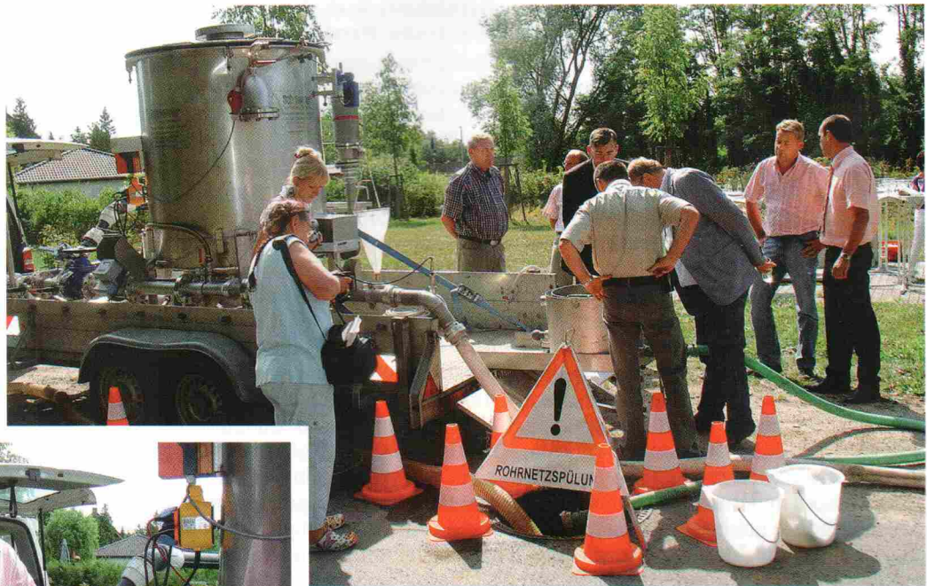
BRIESELANG: Kohlendioxidspülung der Wasserrohre
